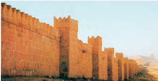
Reconstrução das muralhas da cidade de Ninive, do século VII a. C., que alcançaram um perímetro de 15km.
