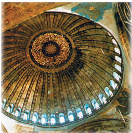
Cúpula da Igreja de Santa Sofia.
