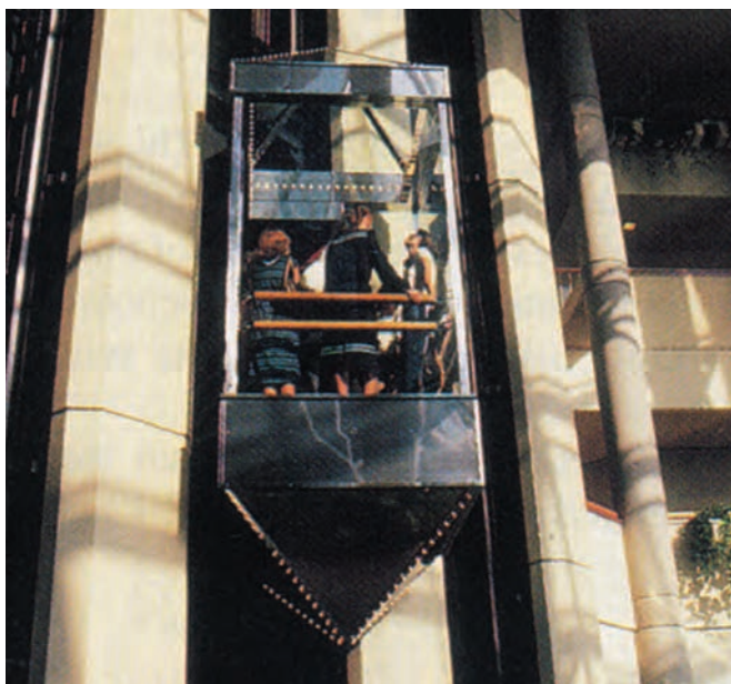
Para a rápida ascensão do elevador, é necessária a implementação de grande potência por parte dos motores que o tracionam.
