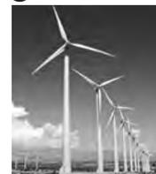
Uma turbina eólica converte a energia contida no vento em energia elétrica. O vento empurra as pás da turbina, fazendo-as girar. Um eixo acoplado às pás transmite a rotação destas
