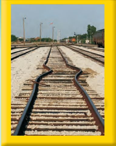
O calor pode provocar variação da temperatura, mudança de estado físico e dilatação térmica
