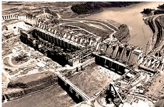
Usina Hidrelétrica de Itaipu
