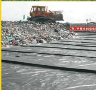
No aterro sanitário, o solo é impermeabilizado, há um sistema de drenagem para o chorume e gases.
